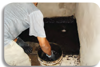
Aplicação da primeira camada de emulsão e posteriormente do Bidim VP. Aplicación de la primera capa de emulsión y posteriormente del Bidim VP.
