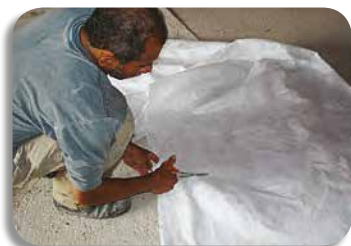
Limpeza da área e corte do Bidim VP na dimensão necessária. Limpieza del área y cortar Bidim VP en el tamaño requerido.
